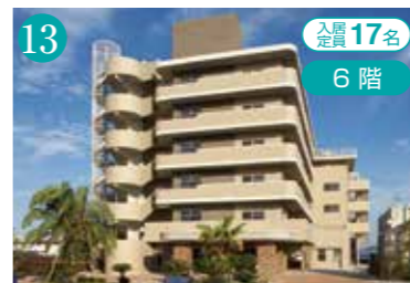
13 入居定員 17名 住宅型有料老人ホーム (デイサービスセンター併設) オシャンビュー湘南荒崎II 神奈川県横須賀市長井5-25-1 (6階) ☎京急久里浜線「三崎口駅」よりバス 圏250,000円 月230,000円
