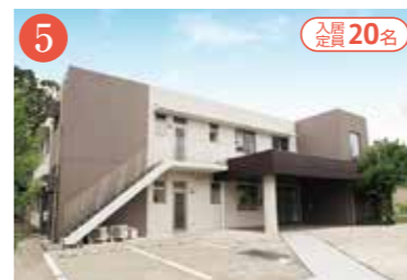
住宅型有料老人ホーム 福寿 かわさき多摩南生田 神奈川県川崎市多摩区南生田2-16-13 ☎小田急小田原線「読売ランド前駅」より徒歩 ☎210,000円 ①139,500円
